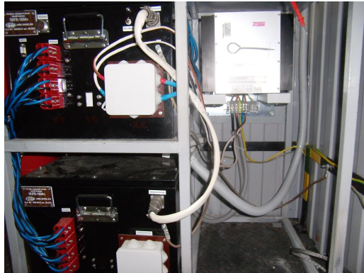
б) U_{\text{ном}}=51\text{В} , C=180\text{А}\cdot\text{ч} , P_{\text{зар}}=1,0\text{кВт}/\text{кг} P_{\text{разр}}=1,3\text{кВт}/\text{кг}
