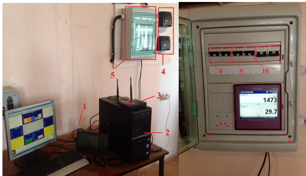
Рис. 3. Измерительная часть лабораторного стенда : 1 – Консоль метеостанции, 2 – управляющий компьютер, 3 – 3Gмаршрутизатор, 4 – контроллеры заряда, 5 – щит управления, 6 –Параграф PL3, 7 – индикаторы работы нагрузки для первого и второго каналов соответственно, 8, 9, 10 – автоматические выключатели солнечных модулей, аккумуляторных батарей и нагрузки для первого и второго каналов, соответственно
