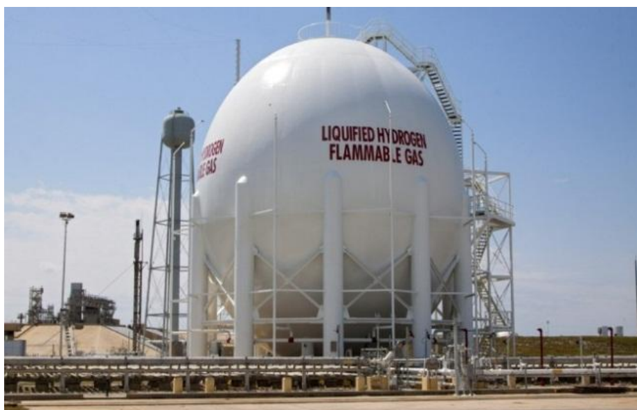
Рис. 2. Хранилище жидкого водорода
