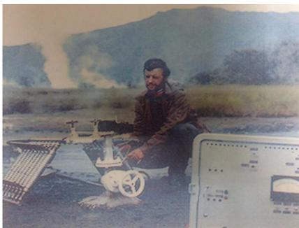
Рис.10. Геотермальный термо-электрический генератор
