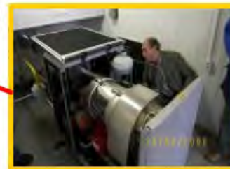
Когенерационный модуль с двигателем Стирлинга электрической мощностью 9,5 кВт
